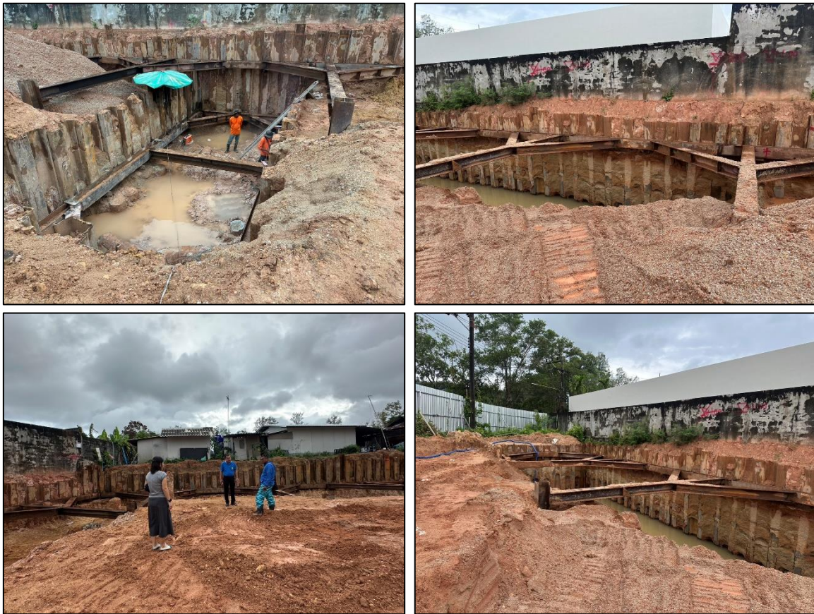
รูปที่ 4.1.2-2 กำแพงกันดินชั่วคราว (Steel Sheet Pile) และทำเหล็กค้ำยัน (Bracing) ปัจจุบันภายในโครงการ
